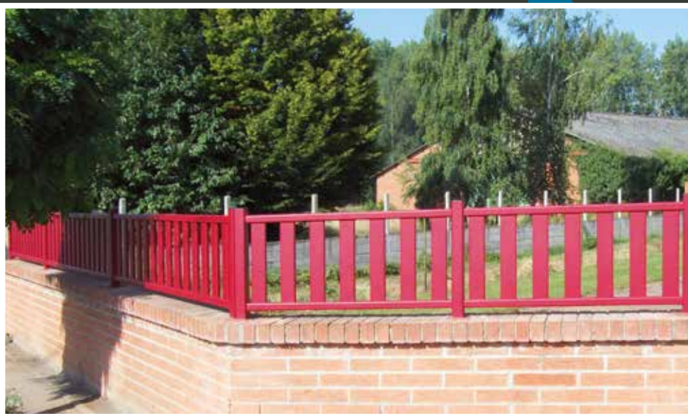
Clôture alu avec lames verticales sur muret
