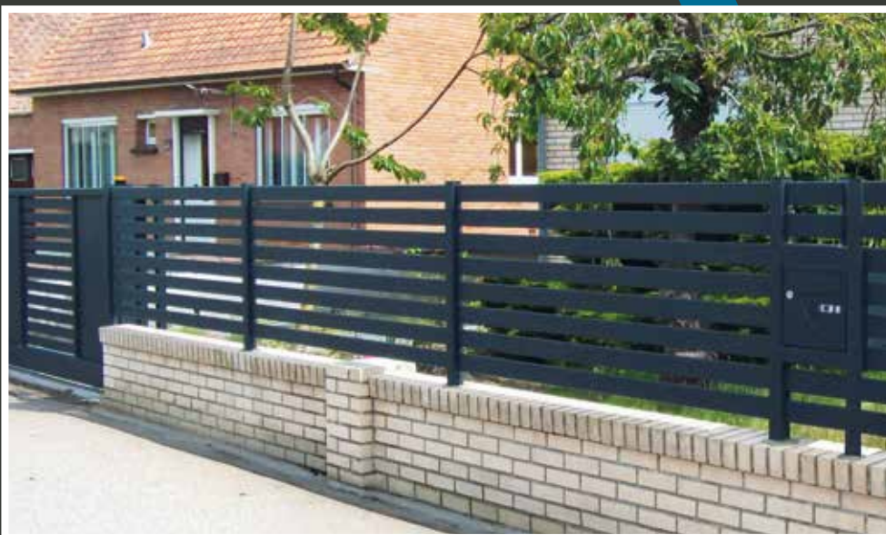
Ensemble lames horizontales espacées sur muret
